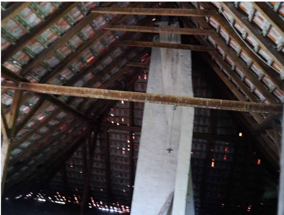
Dachgeschoss, keine Isolierung, schadhafte Ziegel sind deutlich zu sehen
