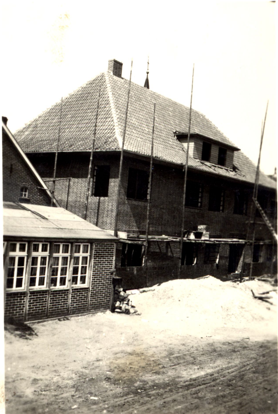
Die Baustelle von 1936, vorn links die behelfsmäßige Unterkunft für die Familie
