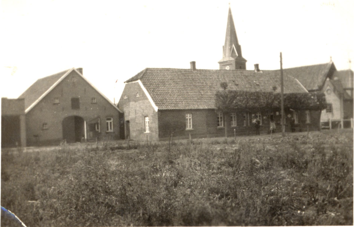
Der Vorgängerbau des Hauses Westhoff auf einem Foto von ca. 1924. Links der Pferdestall, rechts davon das Wirtschaftsgebäude. Das Haupthaus zeigt an der linken Giebelwand Flecken von Umbaumaßnahmen
