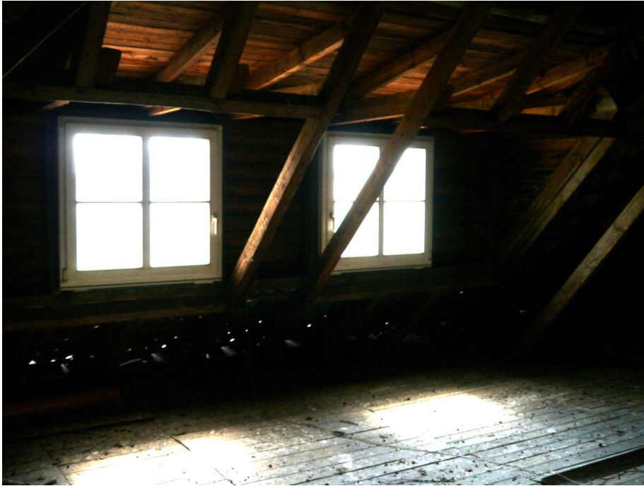
Der vordere Dachausbau
