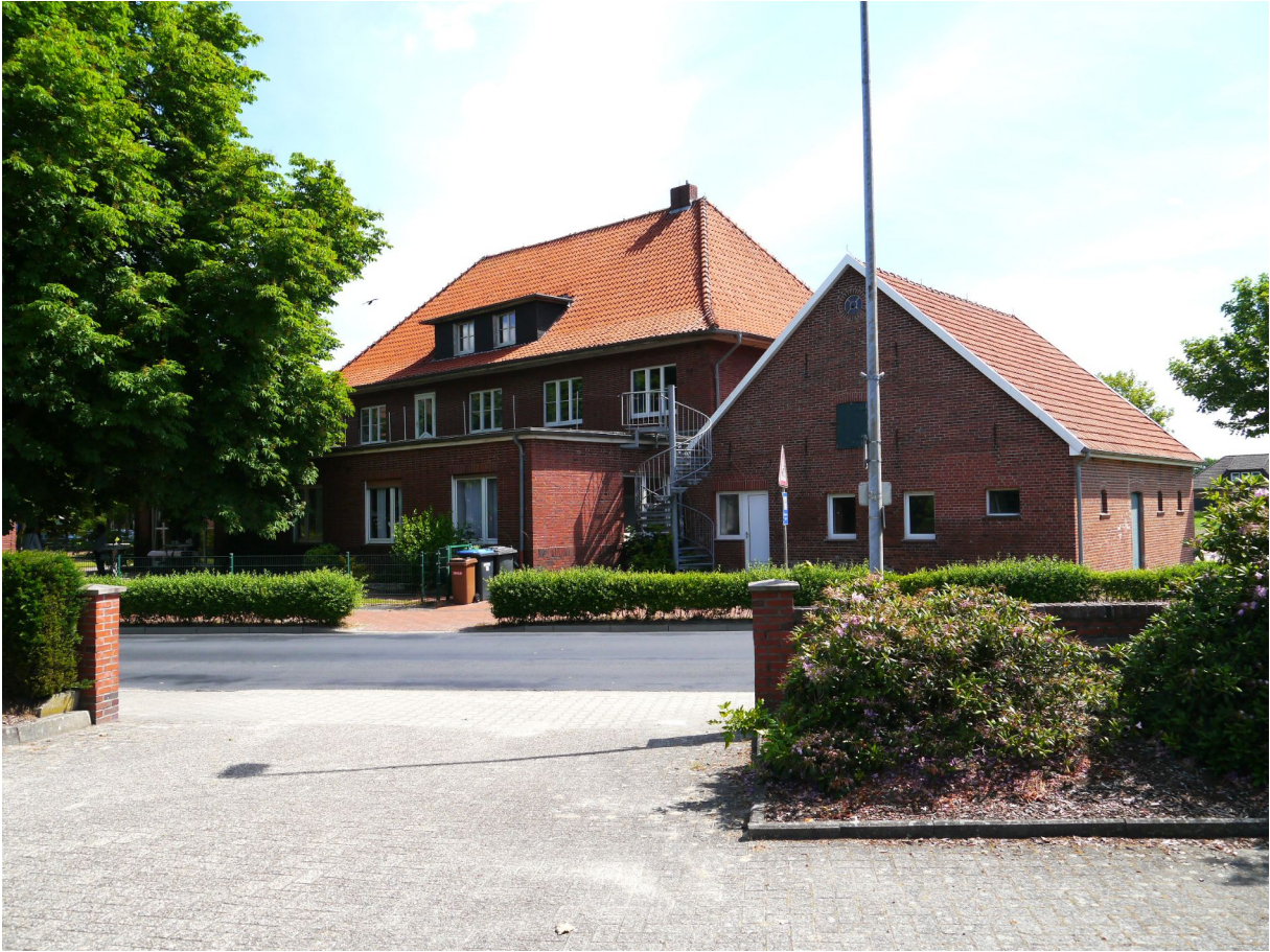
Ansicht der Rückseite des Hauses von 2021
