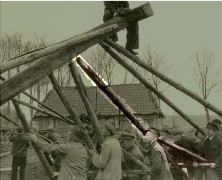
Das Aufstellen des Hauptständerwerks inklusive der Dachsparren auf der Hauptbalkenlage sollte an einem Tag erledigt werden.
