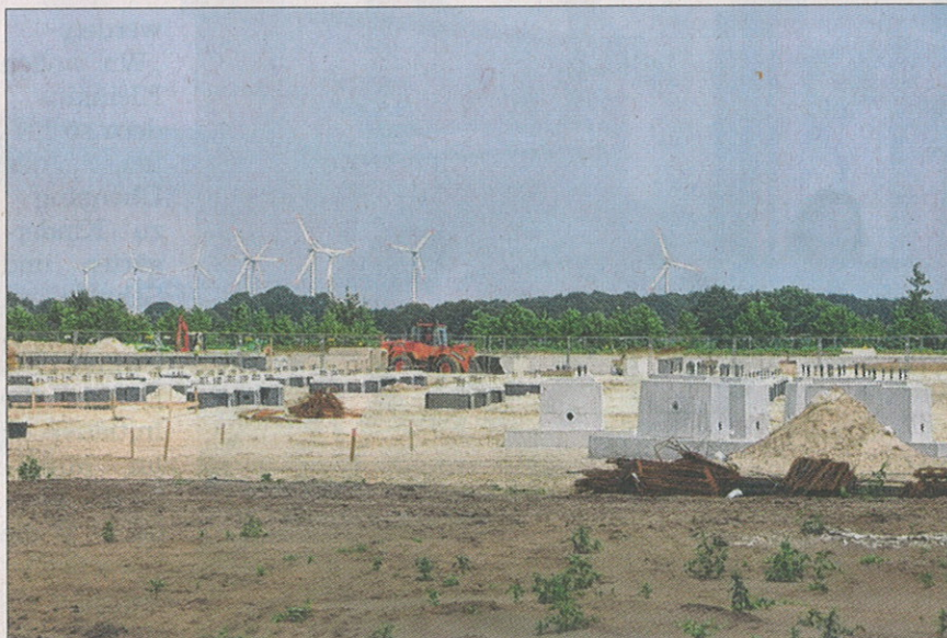
Ein Containerdorf sowie schwere Baumaschinen bestimmen das Bild auf der Baustelle des Umspannwerkes in Heede. Bild: Eden
