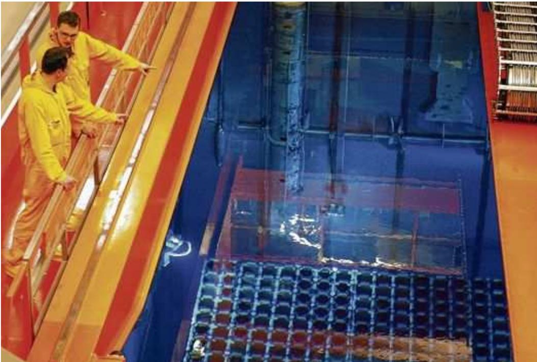
Zwei RWE-Kraftwerkstechniker stehen auf der Brücke über dem Abklingbecken des Kernkraftwerks Emsland in Lingen. Im zehn Meter tiefen, gleich neben dem Reaktorbehälter gelegenen Abklingbecken werden die
